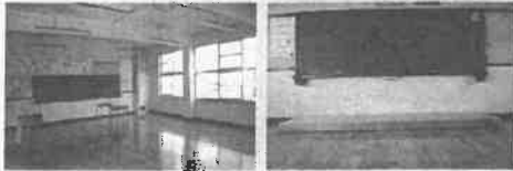
内装工事後の教室
