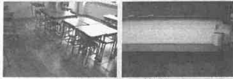
内装工事前の教室
