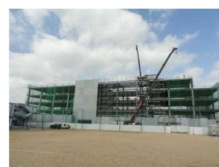
鉄筋建方工事
