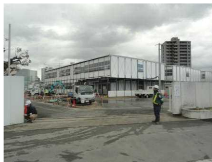
仮設校舎建築
