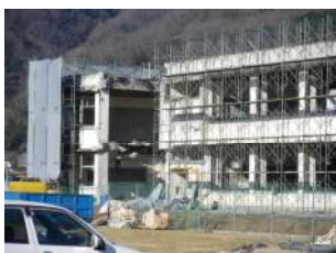
校舎解体作業1月末
