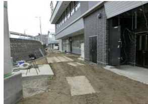
校地内北側から
