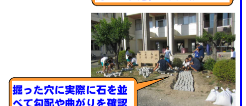
歩道のカーブと坂の具合を見ながら道幅に穴を掘る
