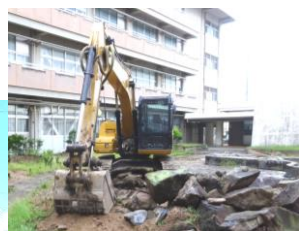
「中庭改修工事」
