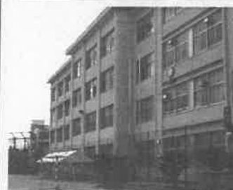
改築前の現校舎
